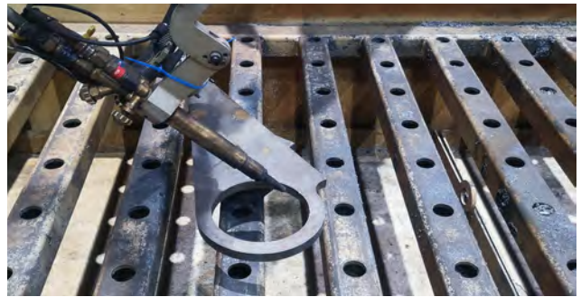
开坡口切割实际现场
