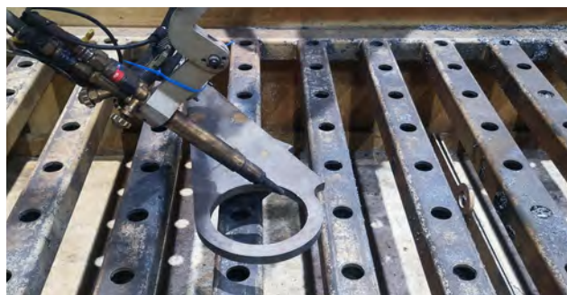
开坡口切割实际现场
