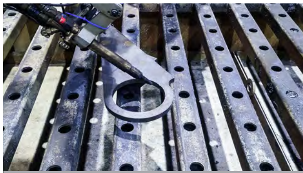
开坡口切割实际现场
